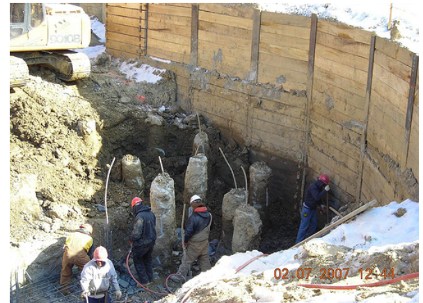
Fig. 3: Auger cast mini piles
